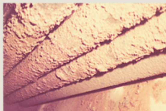
ตะกรันเกาะที่หม้อต้มไอน้ำ
